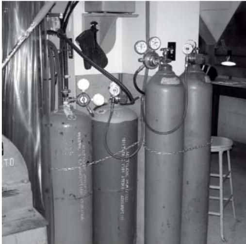
Les cylindres de gaz doivent toujours être attachés avec des chaînes métalliques et fixés au mur.
